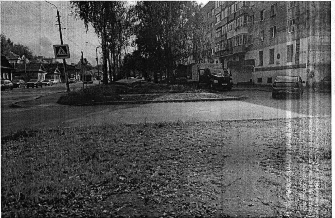
Фото 1. Контроль производства работ на участке тепловой сети у К-20а, между домами по адресу Калиновская, 22-24 (работы не ведутся)
