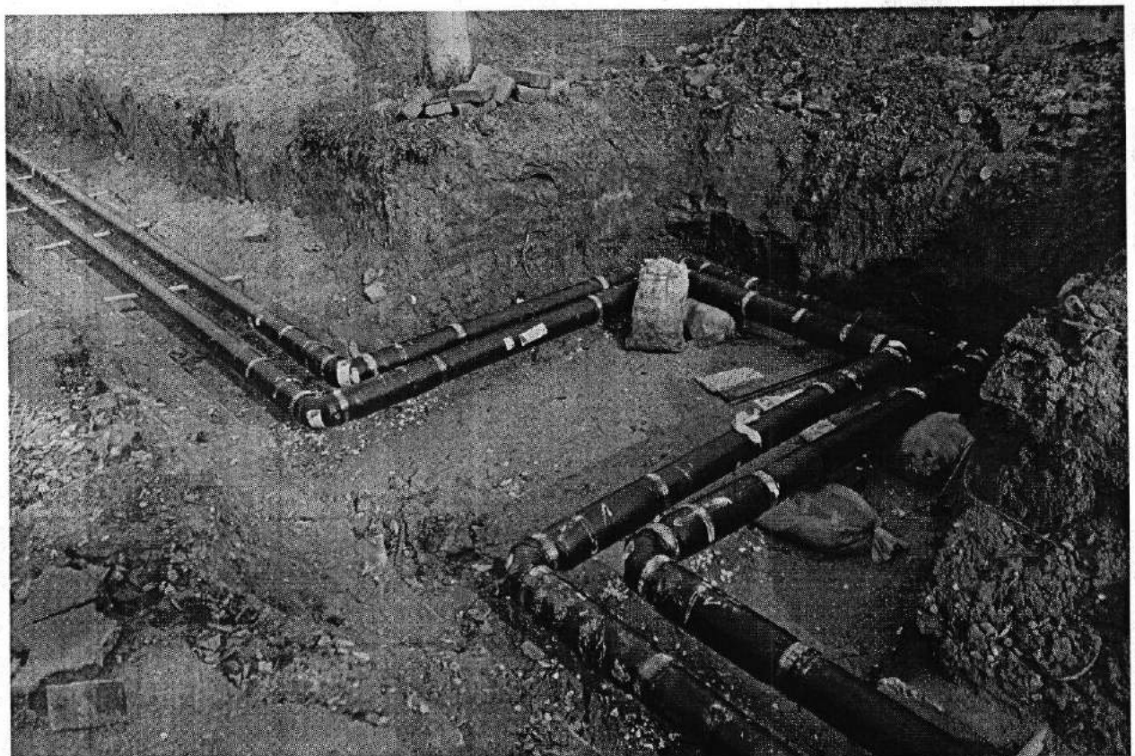
Фото 4. Контроль производства работ на участке тепловой сети ск8-ск11 (П-образный компенсатор на участке от камеры ск8 до камеры ск11 развёрнут в сторону дорожного полотна по ул. Пушкина)
