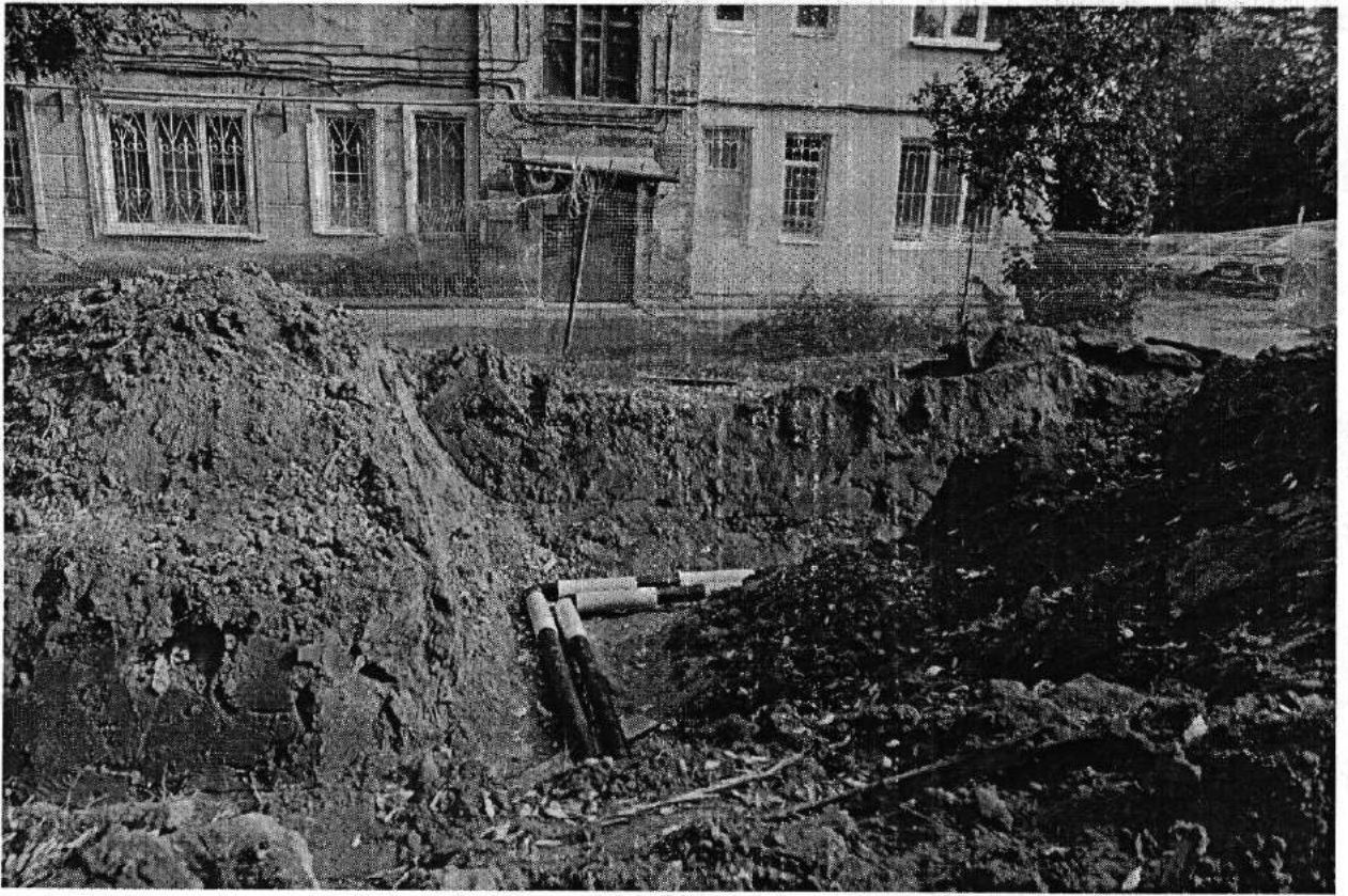
Фото 11. Контроль производства работ на участке тепловой сети ск1-ввод в жилой дом по адресу ул. Ленина, 90 (ведётся производство работ)
