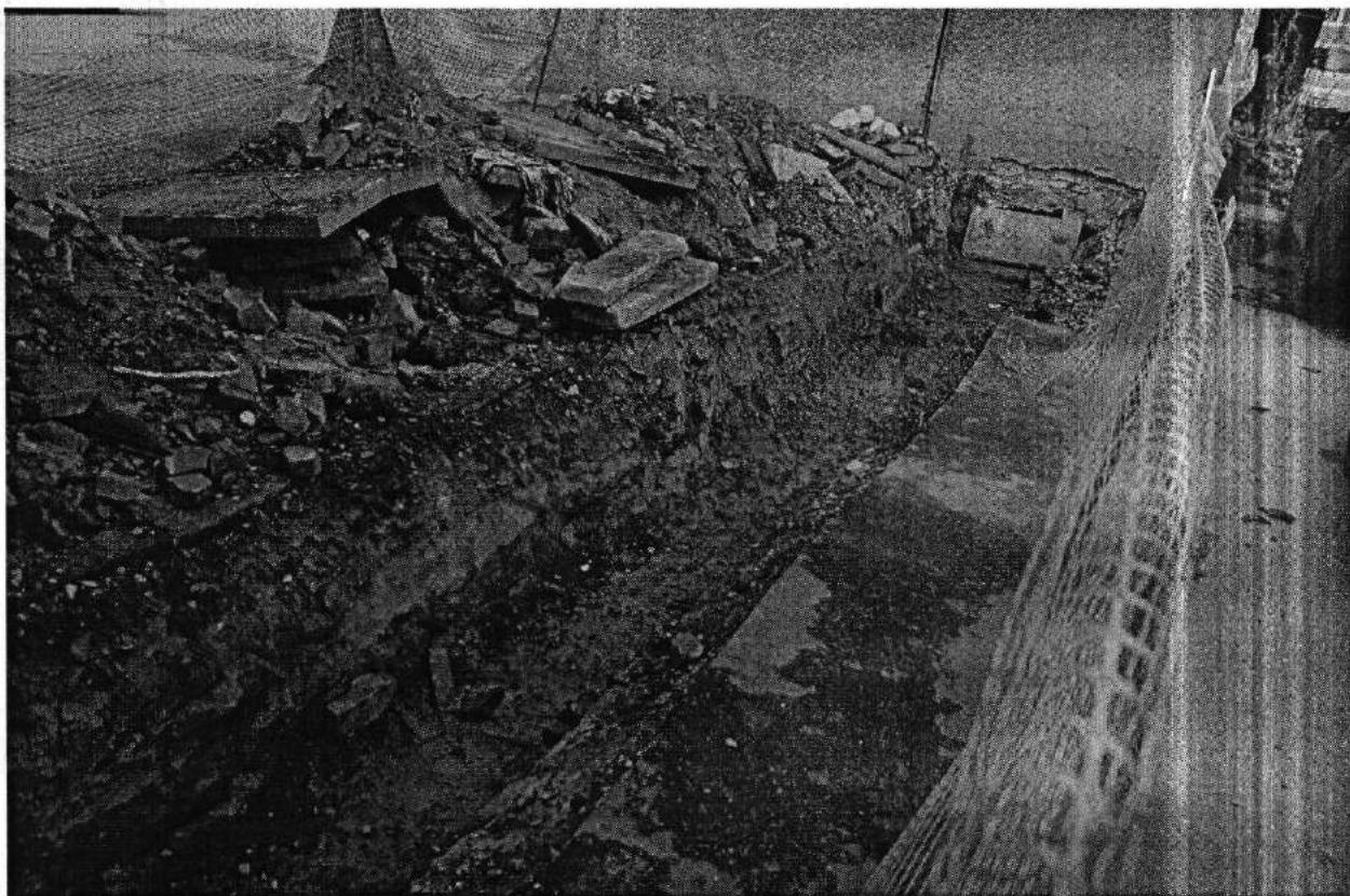
Фото 9. Контроль производства работ на участке тепловой сети ск12а-ск13 (участок между домами адресу ул. Пушкина, 38-40)
