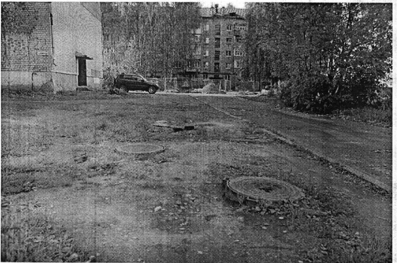
Фото 4. Контроль производства работ на участке тепловой сети ск3-ск4 (работы не ведутся)
