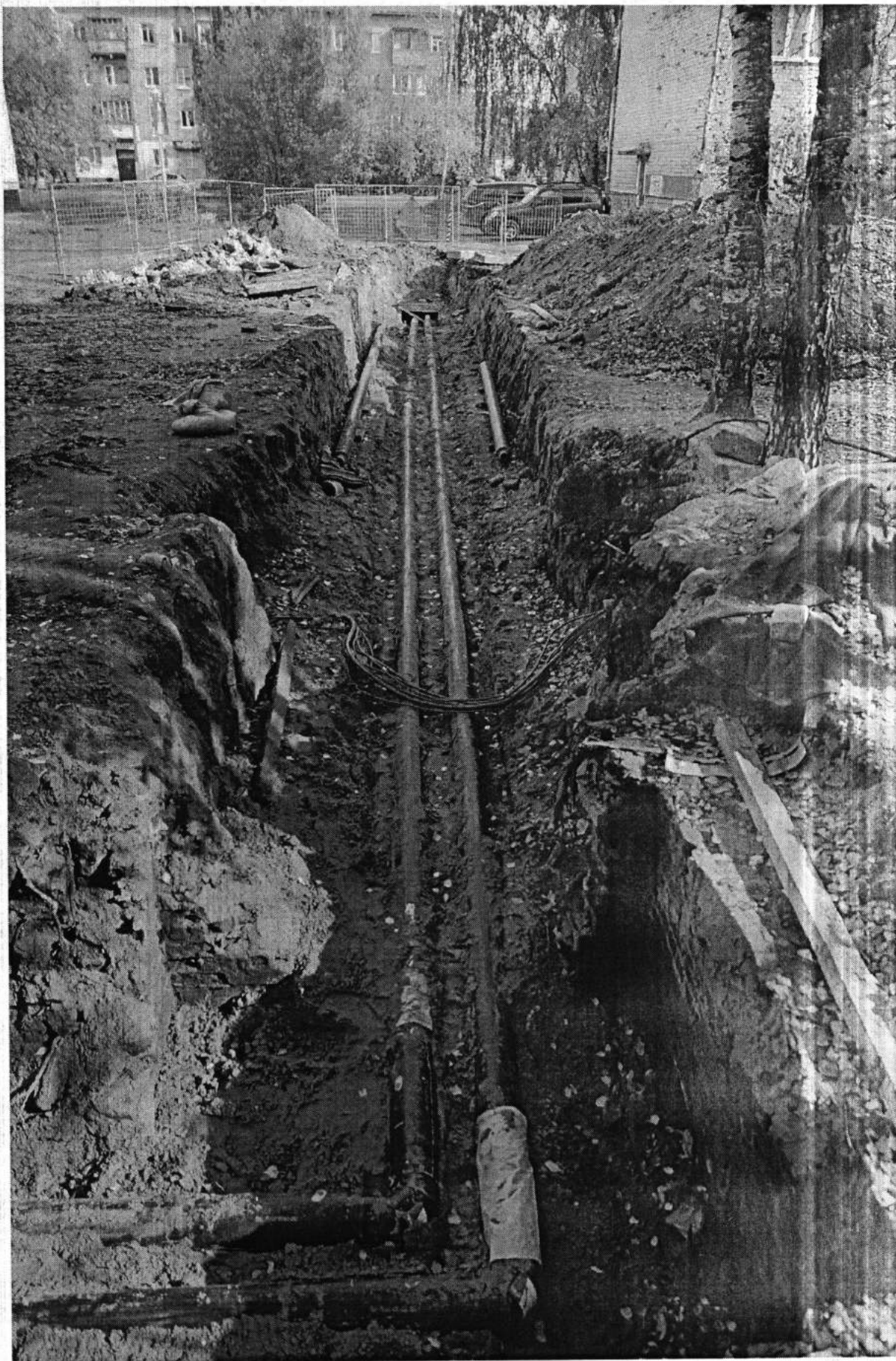
Фото 5. Контроль производства работ на участке тепловой сети ск4-ск5 (производство работ, вид от ск5 в сторону ск4)
