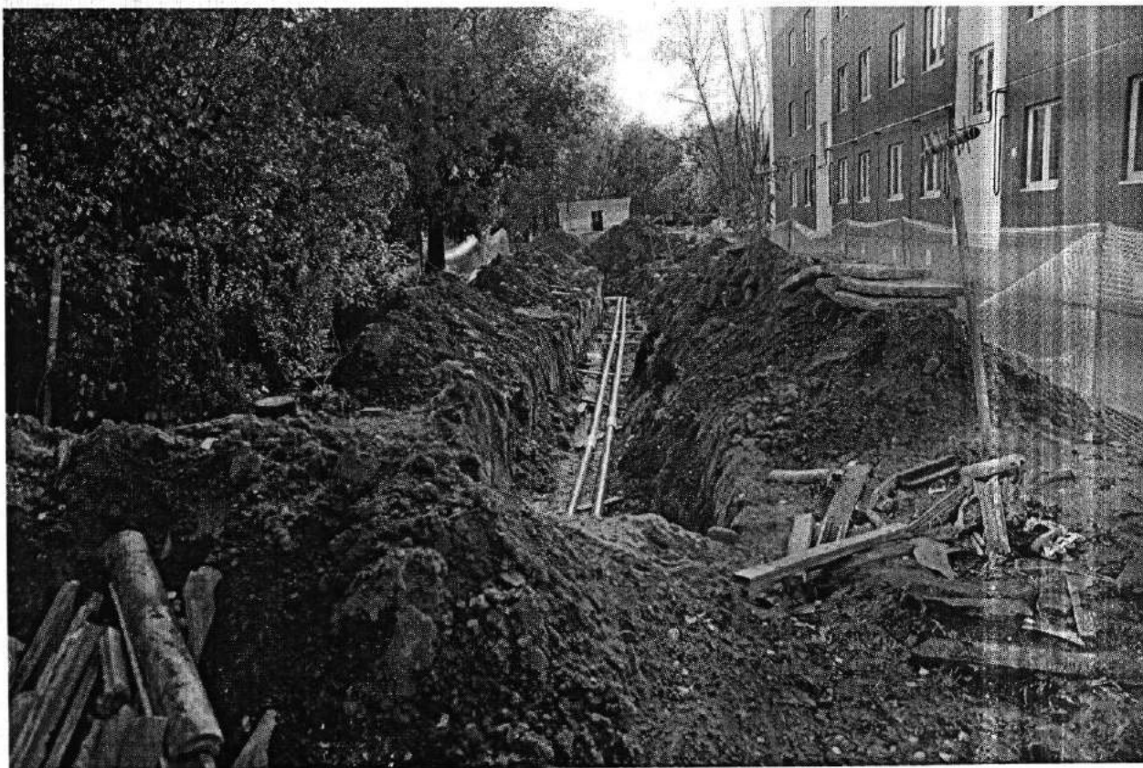
Фото 10. Контроль производства работ на участке тепловой сети ск1-ввод в жилой дом по адресу ул. Ленина, 90 (ведётся производство работ)
