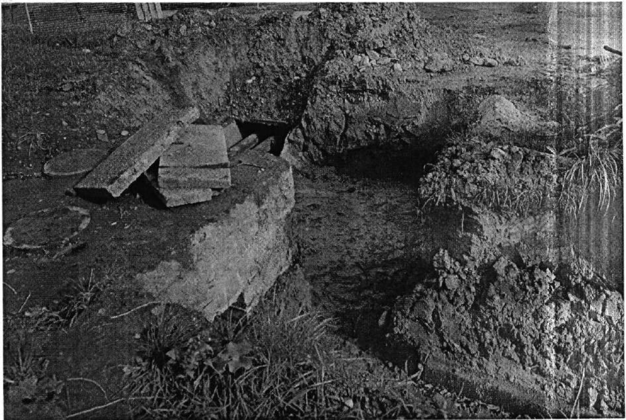
Фото 6. Контроль производства работ на участке тепловой сети у ск11 (трассировка сетей осуществлена без использования камеры ск11)
