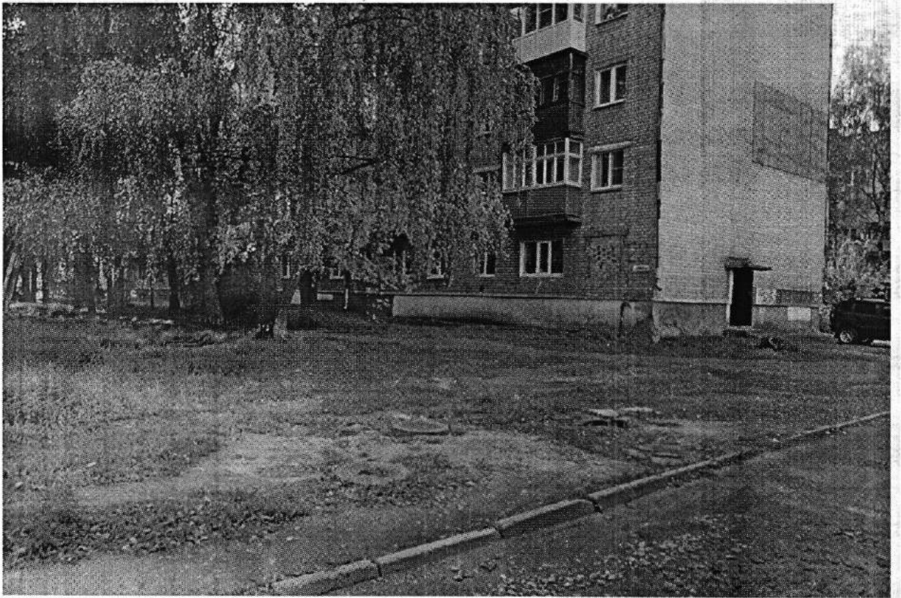
Фото 3. Контроль производства работ на участке тепловой сети ск3 (работы не ведутся)
