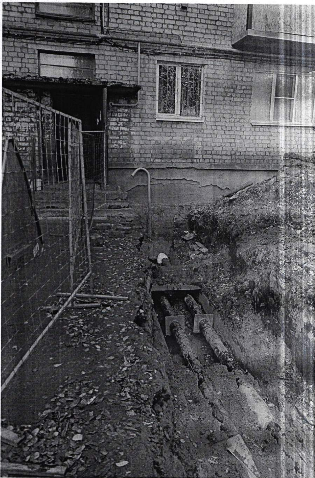
Фото 8. Контроль производства работ на участке тепловой сети ск5-ввод в дом по адресу ул. Калиновская, 20
