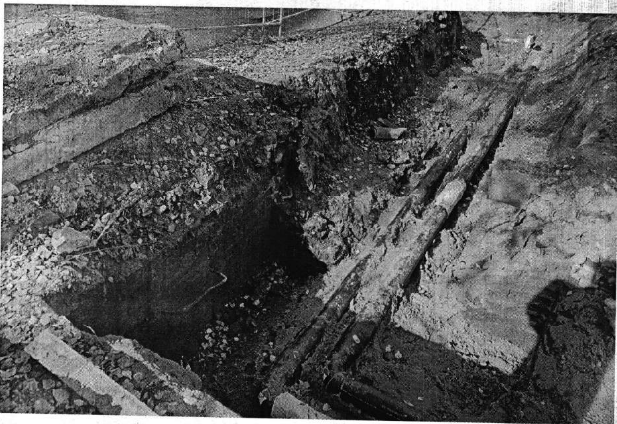
Фото 7. Контроль производства работ на участке тепловой сети в районе ск5 (частичное разрушение кирпичной кладки стенок камеры ск5)
