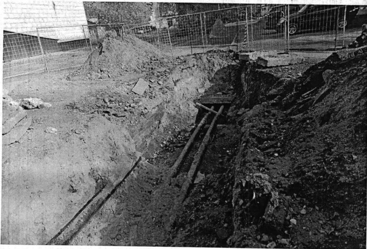
Фото 6. Контроль производства работ на участке тепловой сети в районе ск4 (частичное разрушение кирпичной кладки стенок камеры ск4)
