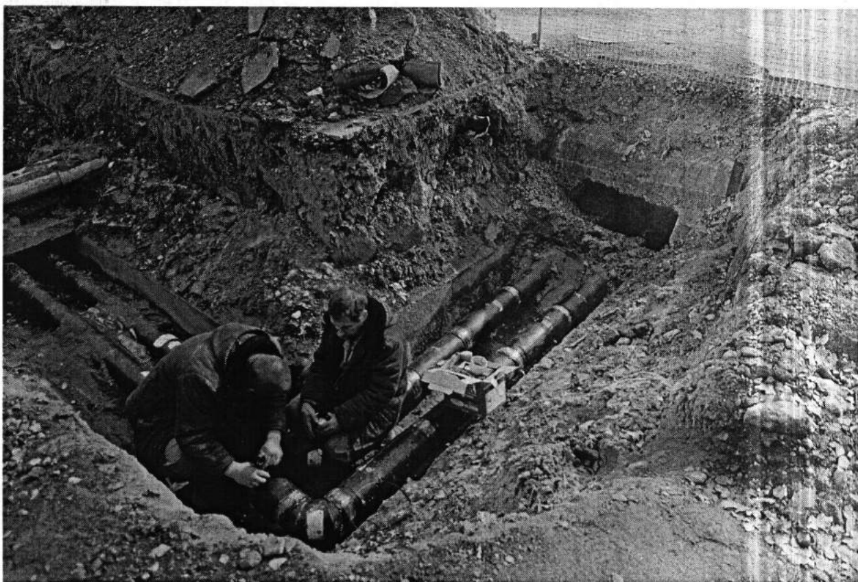
Фото 2. Контроль производства работ на участке тепловой сети ск8-ск11 (производство работ в районе камеры ск8)
