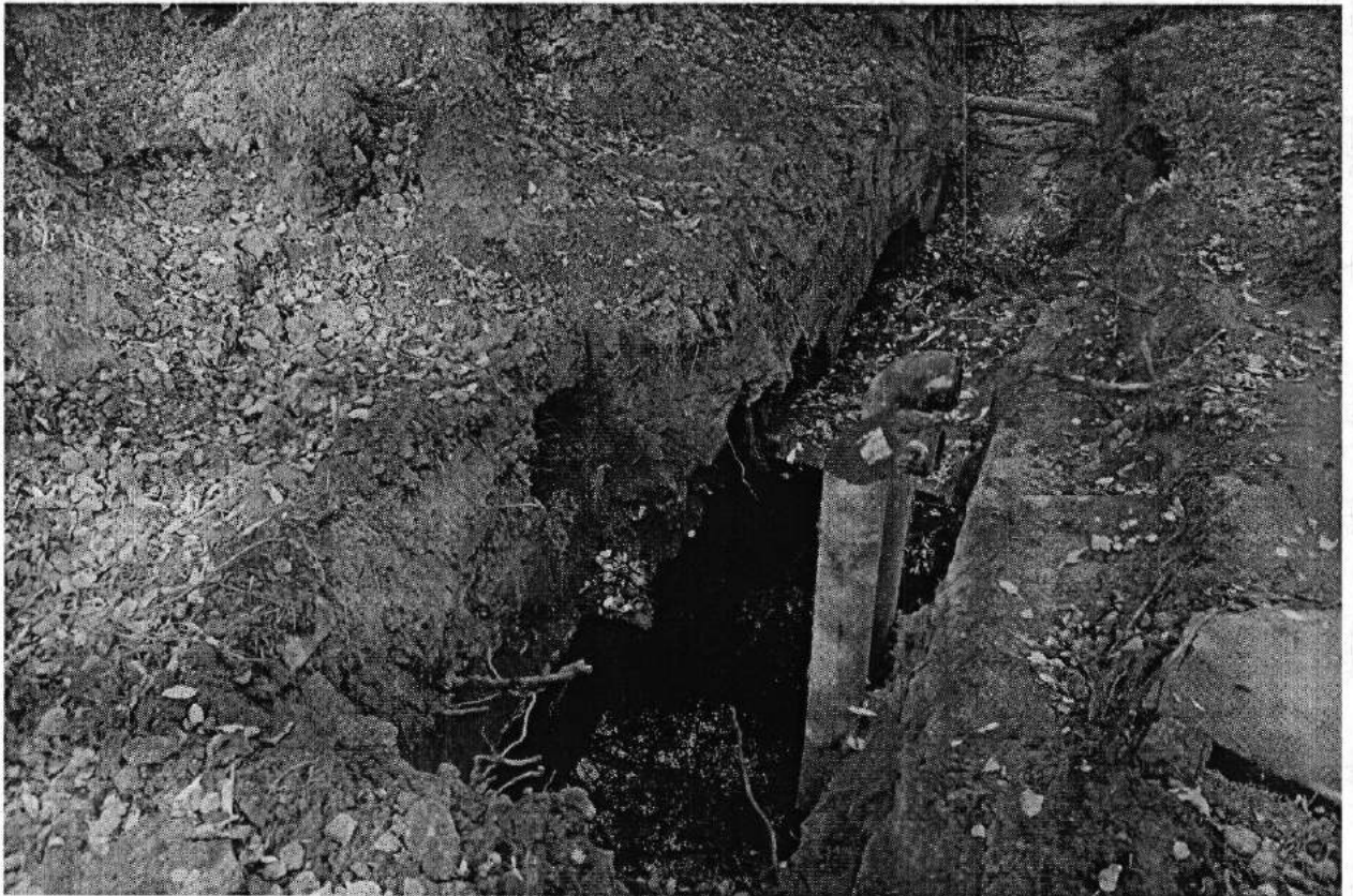
Фото 7. Контроль производства работ на участке тепловой сети ск11-ск12 (выход тепловой сети в районе камеры ск12 по направлению к многоквартирному дому №38 по ул. Пушкина)
